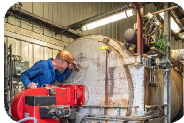
Aanpassing brander Nedmag mijnlocatie t.b.v. bijmengen waterstof 0-100%
